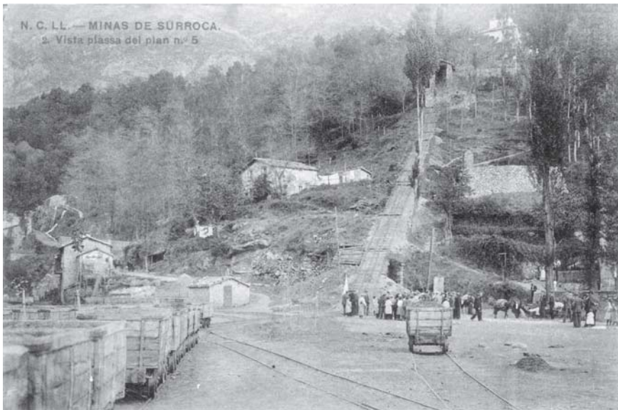
Figura 15. La Plaça Dolça, donde se concentraban las vagonetas con el carbón, a fin de transportarlo hasta la estación de carga de Toralles. Entre 1910 y 1918. Cortesía de Agustí Dalmau i Font.
